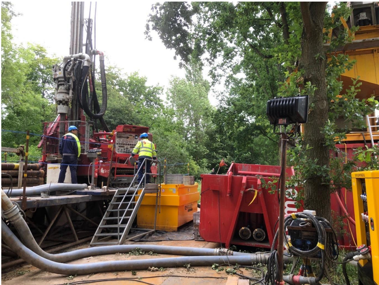
Figuur 3-2. Voorbeeld van een verhoogde opstelling van de boorinstallatie en de mantelbuis tijdens een zuigboring.
